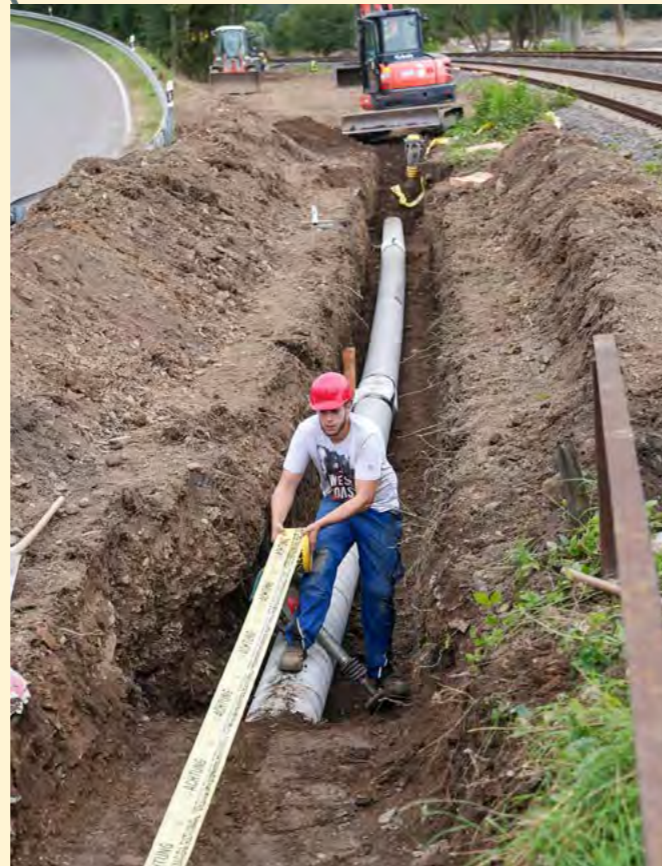
Verlegung der neuen Hochdruckleitung zwischen Heppingen und Lohrsdorf. (Foto: evm-Gruppe)
